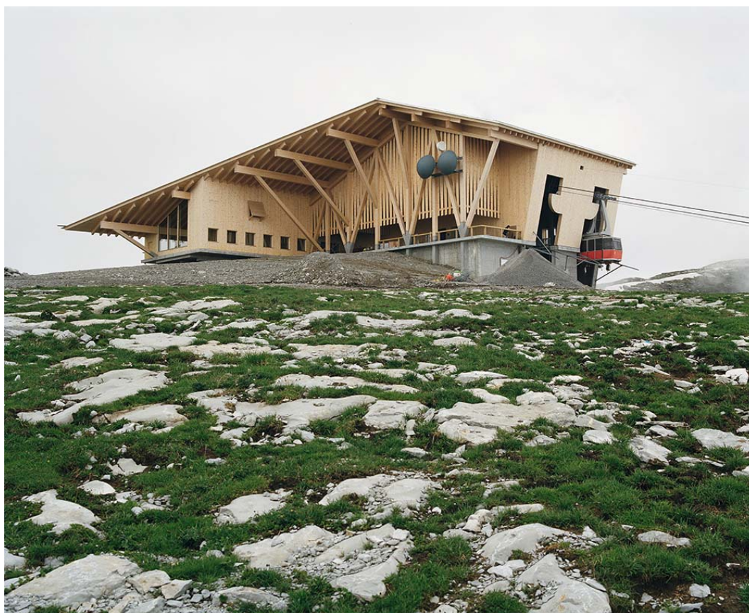
Stazione di monte della funivia Chäserrugg-Toggenburg (Svizzera), arch. Herzog & De Meuron
