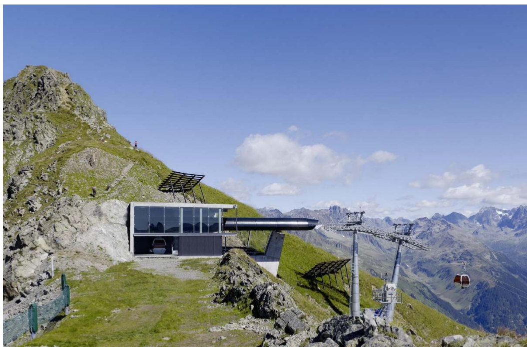
Impianto di Silvretta Montafon Bergstation (Austria)
